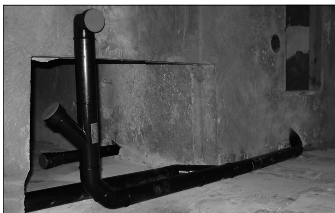
Figur 6.2 Prefabricerade rörsektioner installerade på byggnadsplatsen
