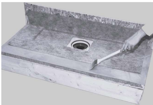
11. Addera Byggmax Folielim och Byggmax Tätmembran på övrig golv / väggyta. Stryk ut limmet med fintandad limspredare alt. Pensel.
