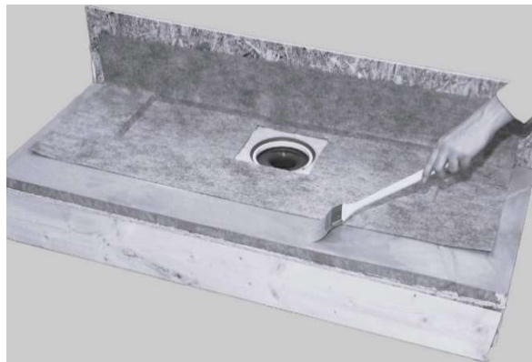
10. Addera LIP 2K Folielim på övrig golv och väggyta. Stryk ut limmet med fintandad limspredare alt. Pensel.
