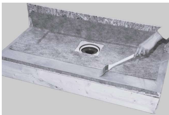
11. Applicera Alfix 2K Tätmembran på övrig golv och väggyta. Stryk ut limmet med fintandad limspredare alt. pensel.
