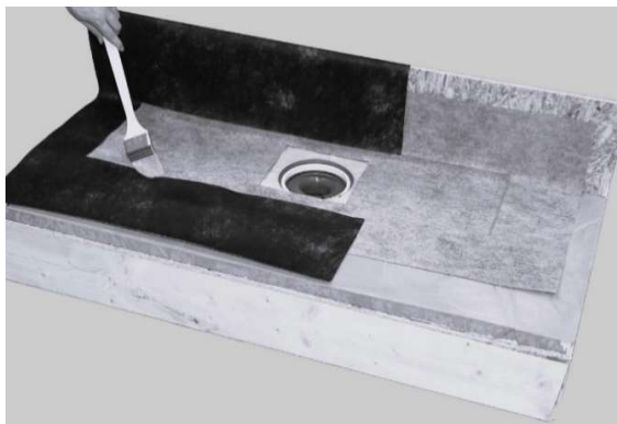
12. Montera Alfix Våtrumsmatta Pro, överlappa manschetten med minimum 50 mm. Förslut samtliga skarvar runt manschetten med Alfix 2K Tätningsmassa.
