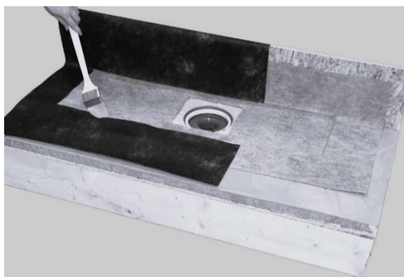
11. Montera LIP väggfolie och överlappa manschetten med minimum 50mm. Förslut samtliga skarvar runt manschetten med LIP Skarvlim MSP.
