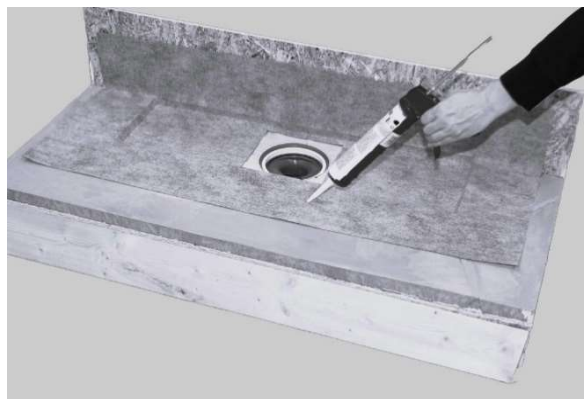
10. Addera Byggmax Folielim ca 50mm in på manchetten.
