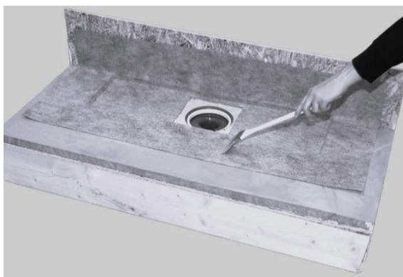
10. Applicera Alfix 2K Tätningsmassa ca 50mm in på manschetten.
