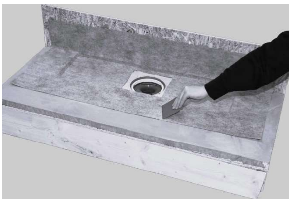
9. Applicera den medföljande tätskitets manchetten och tryck noga fast den. Säkerställ så att inga blåsor eller veck uppstår.
