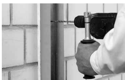
Fästning av C-profiler på väggarna med ljudisolerande polyetenremsa eller mineralullsremsor.
