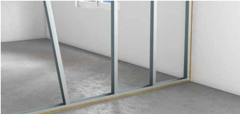
Montering av CW-stålsreglar
