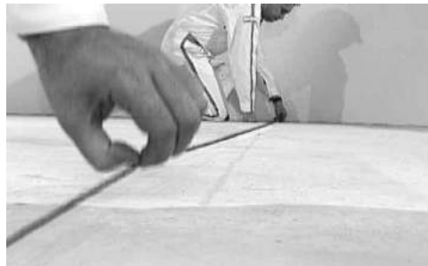
Markering av skiljeväggens placering med en snörslå.
