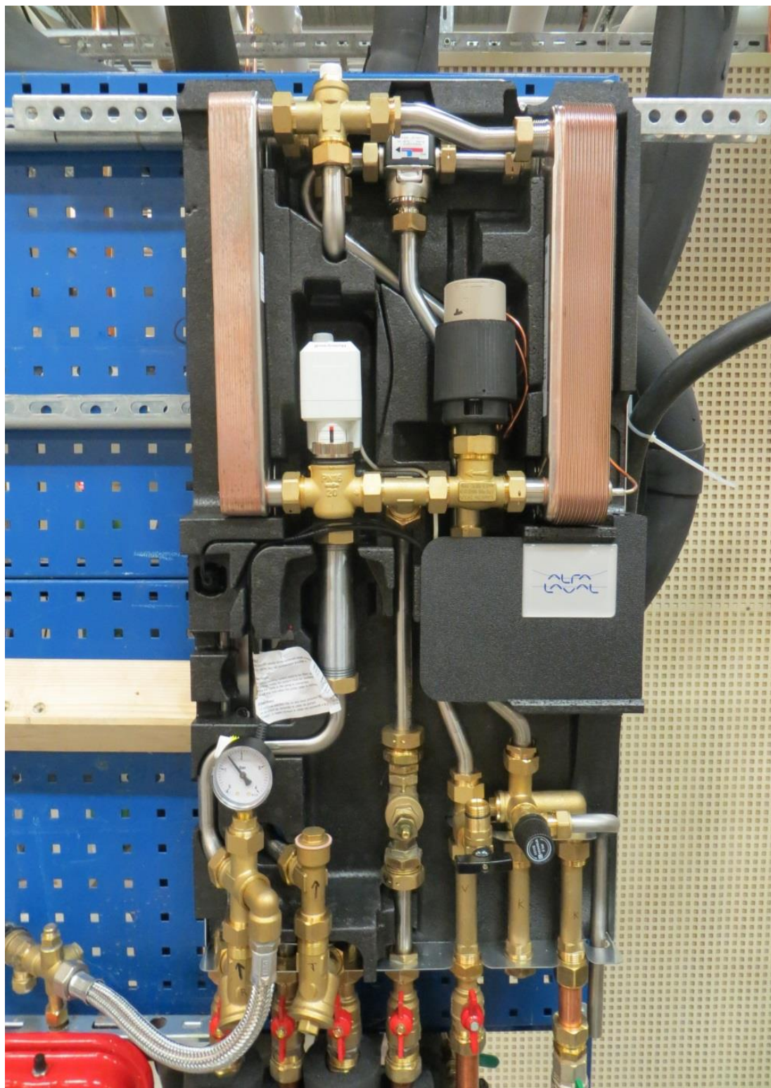
Figur 1. Fjärrvärmecentralen Alfa Laval Mini City vid provning.
