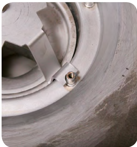
Blücher – Placera insatsen till Blücher Brunnskniv i golvbrunnen. Se till att benen greppar in i muttern. Tornen.
