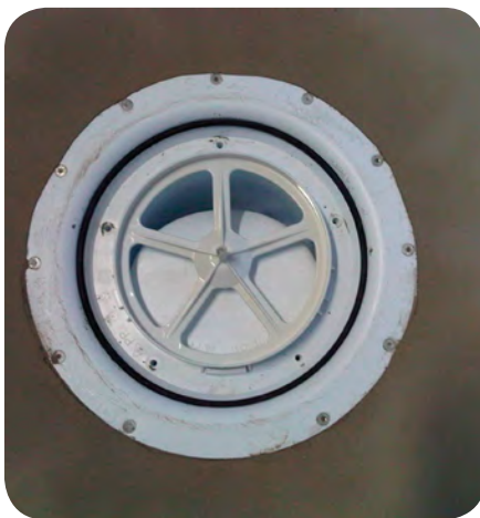
Faluplast – Placera den runda basen av skärmallen i brunnen så att den styr i urtagen.
