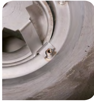
Blücher – Placera insatsen till Blücher Brunnkniv i golvbrunnen. Se till att benen greppar in i muttern. Tornen.
